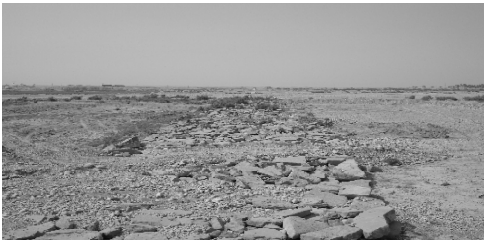
عکس شماره ۲- ریپ رپ‌های قرار گرفته روی سقف سیفون
