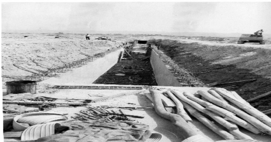
عکس شماره (۱): تصویری از سیفون در حال اجرا
