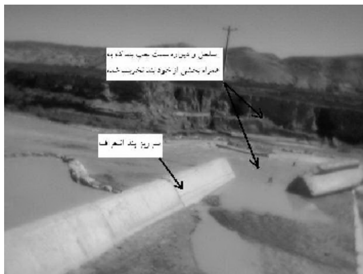
شکل (۲): ساحل چپ بند قدیمی که به کلی تخریب شده است
