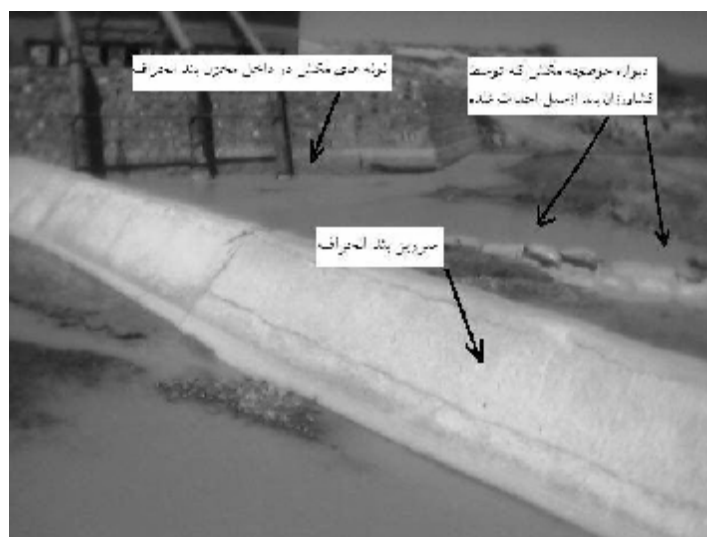
شکل (۳): حوضچه مکش حاوی رسوبات.
