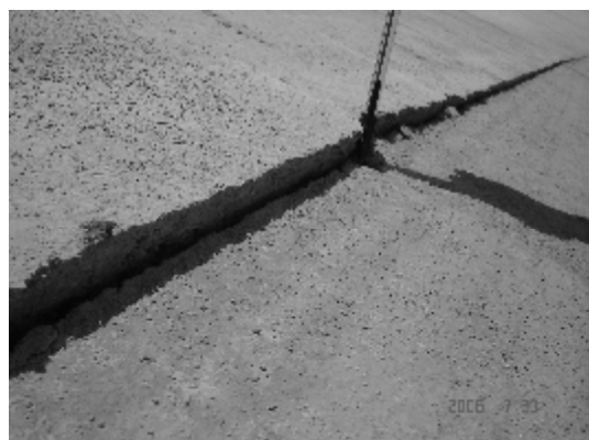
شکل (۴): تصاویری از محل‌های آسیب دیده و شکل شماتیک بالازدگی پوشش
