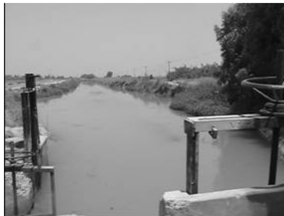
شکل (۵): آب پخش اصلی در انتهای کانال انتقال
