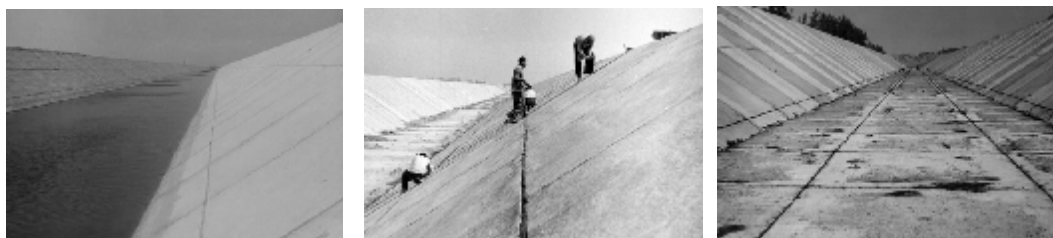
شکل (۲): وضعیت ظاهری پوشش بتنی کانال بعد از سه سال که در حد فاصل بین ساعات ۳ الی ۹ صبح بتن ریزی شده اند
